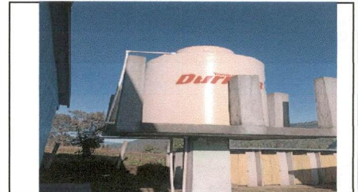
Foto 4: sustitución de deposito de agua 1100 lt
